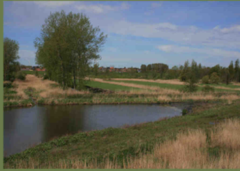
Rechts: tijdens de werken, april 2012. Door de aanleg van de nieuwe dijk is de spaarkom erg verkleind. In de verte heeft het kappen van de Canada's de woningen van Kruibeke zichtbaar gemaakt. (Foto Dirk Gorrebeek)
