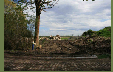
Rechts: tijdens de werken, maart 2012. Het Schoutteehof is verdwenen. Er liggen nog restanten van de funderingen maar het zicht is onbelemmerd tot aan de Schelddijk. (Foto Dirk Gorrebeek)
