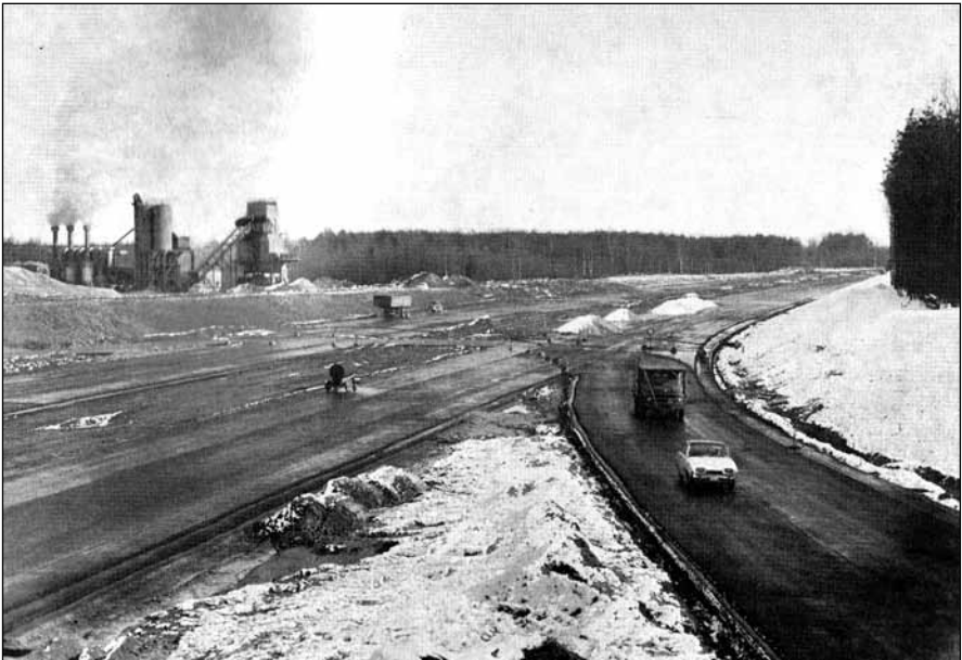
De heidewegels van Romain Malfliet doorsneden door de aanleg van de E3: verharding van de rijbaan van de E3 ter hoogte van Waasmunster (foto Luc De Rammelaere, Jaarverslag Intercommunale Vereniging voor de Autoweg E3, blz. 25)
